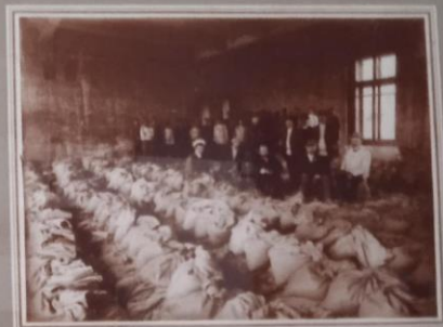
ИСПЫТАНИЕ НА ПРОЧНОСТЬ ПОТОЛОЧНОГО ПЕРЕКРЫТИЯ СТРОИТЕЛЬНОГО КОРПУСА УНИВЕРСИТЕТА Автор проекта железобетонных перекрытий В.А. Лисицкий. 1910-е гг. Копия с оригинала СГМАБ.
